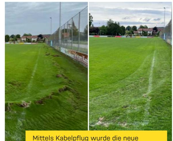
Mittels Kabelpflug wurde die neue Steuerleitung in die Plätze einge-zogen. Auf dem linken Bild sieht man den geöffneten Rasen, rechts sieht man den Zustand nach dem Walzen.
