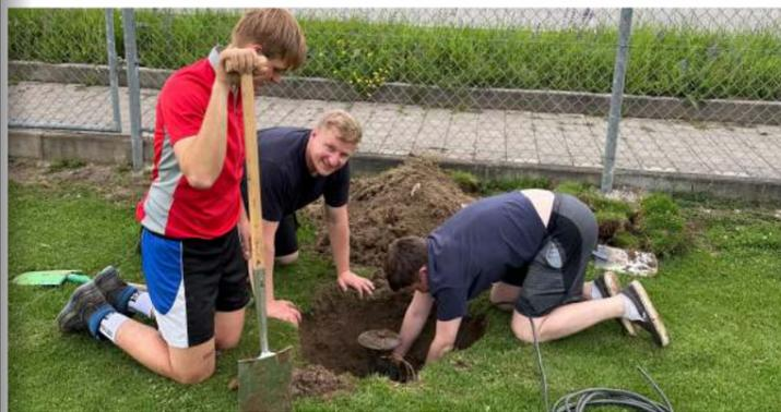
Am 6. Juni wurden die Regner freigelegt, wofür jeweils bis zu 60 cm tief gegraben und Löcher mit einem Durchmesser von rund einem Meter ausgehoben werden mussten.
